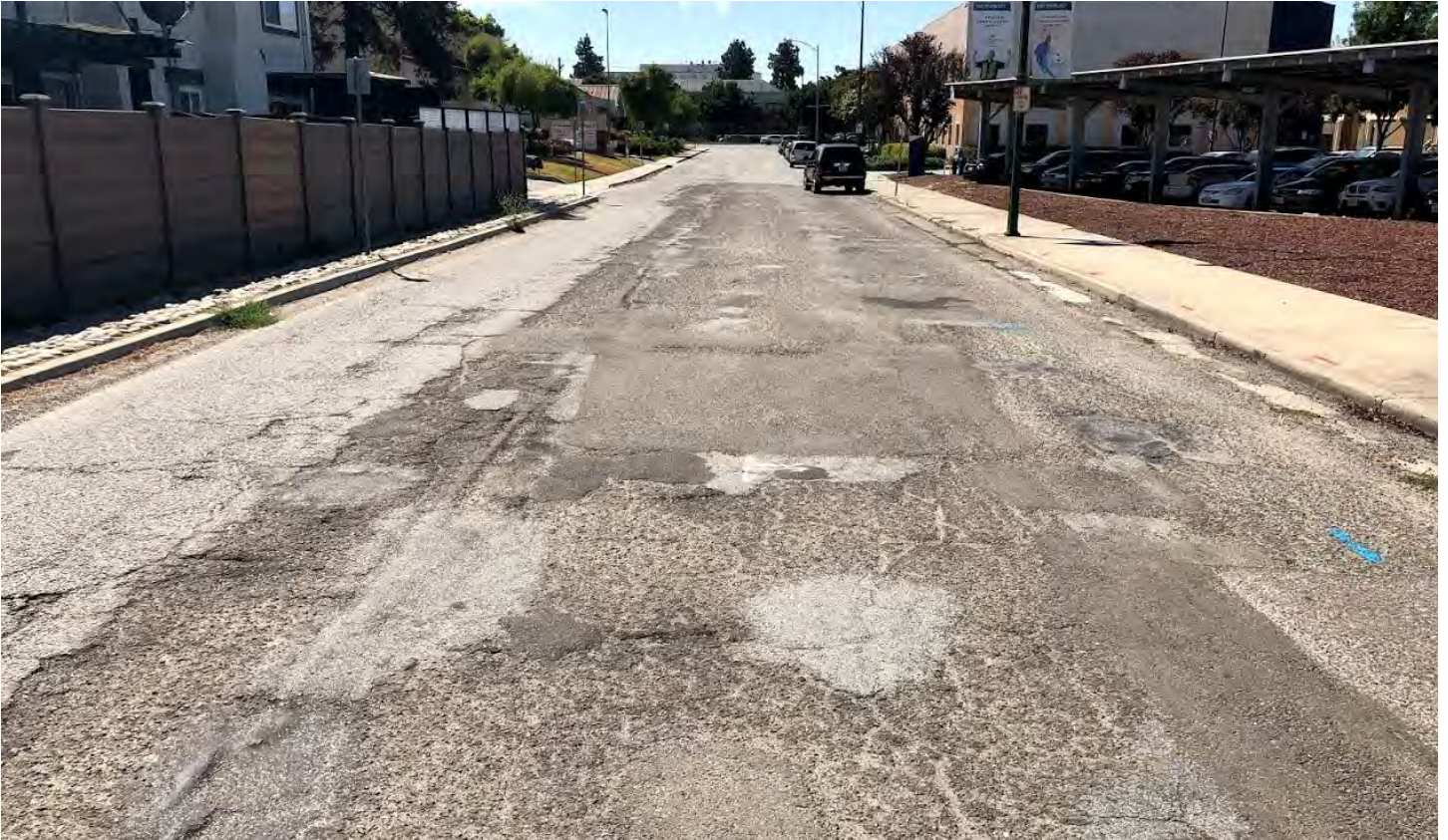
LUDLOW WAY (BEFORE)
