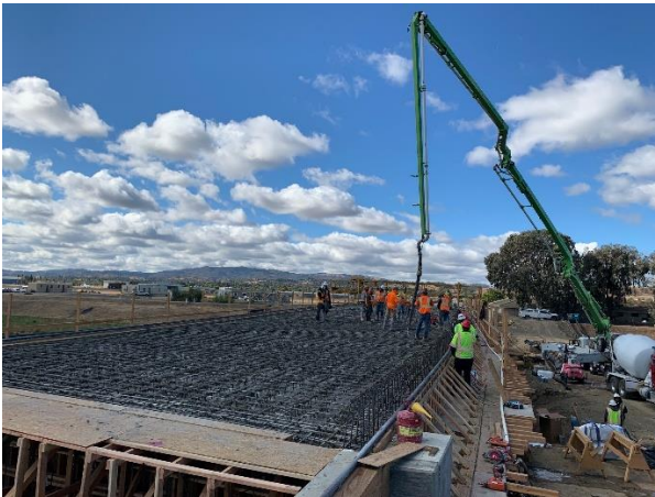
Stage 1 bridge deck pour (10.18.21)
