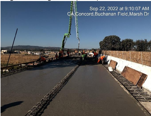
Stage 2 bridge deck pour (9.22.22)
